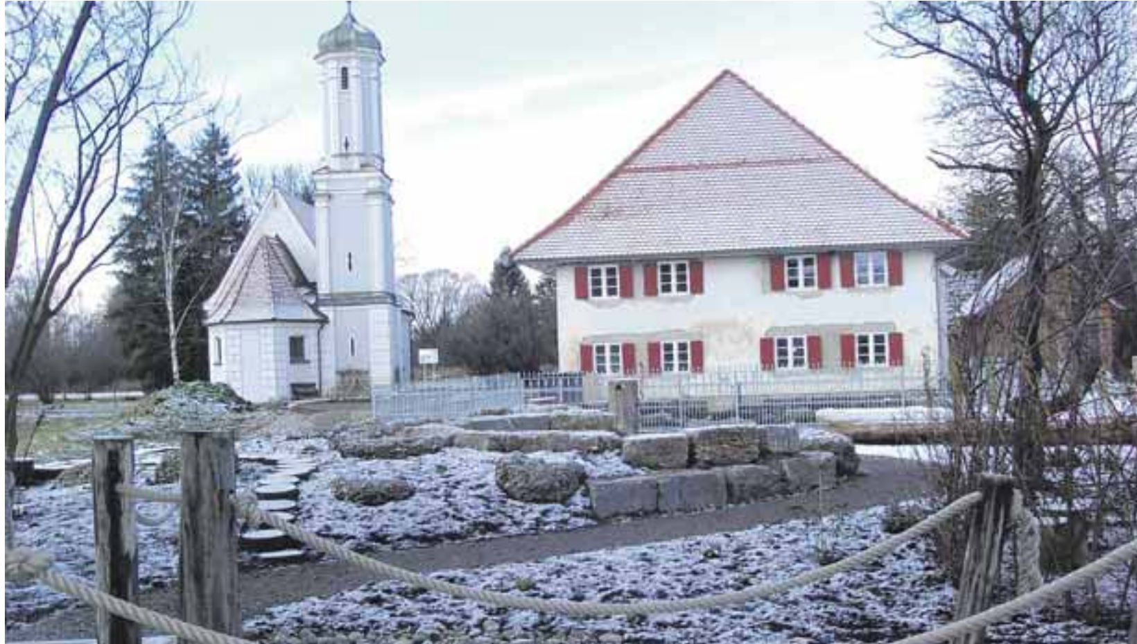
Die Arbeiten im und um das Benninger Riedmuseums kommen voran. Der Themengarten (im Vordergrund) ist bereits zu erkennen.
